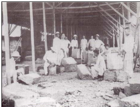
Gambar 6. Tukang batu dan kayu orang Cina berasal dari suku Konghu (asal Guangdong) yang mengerjakan bagian dari lantai, trap, dinding bawah, selasar dan teras serta hiasan ornamen Gedung Sate, Bandung. Mereka ini sangat piawai dan menguasai betul pertukangan kayu dan pengolahan batu alam.
