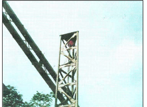
Foto 9. Di tengah pelat segitiga atas digantung takel, alat pengangkat manual yang sangat memudahkan pekerjaan
