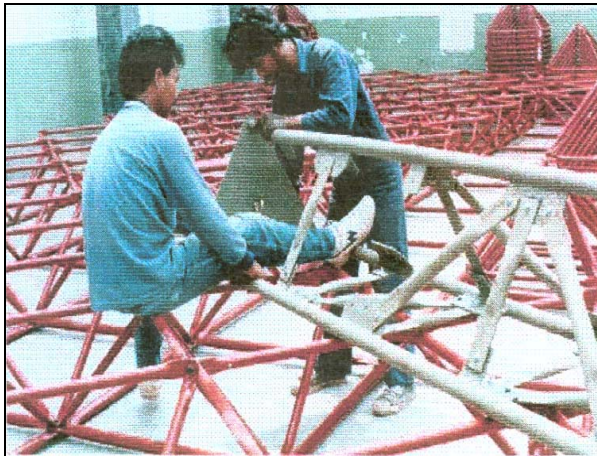
Foto 6. Selesai perakitan seluruh unit, siap untuk diangkat. Sebelumnya dilakukan pemasangan tiang segitiga atau rangka balok vertikal (space beam), tripod, yang dibagian atas digantungkan takel.
