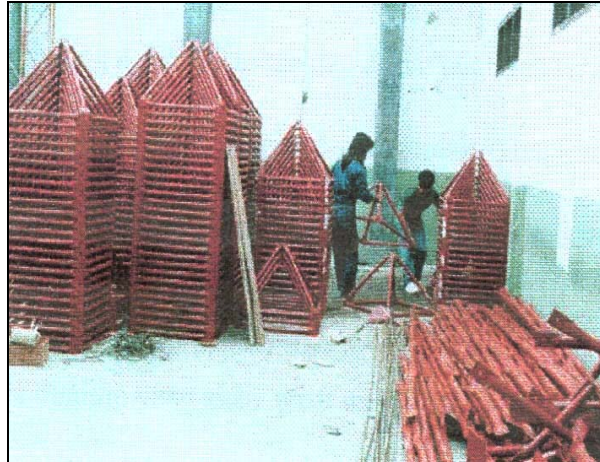
Foto 2. Unit rangka struktur telah sampai dilokasi dan diletakkan pada sisi dinding. Pada bagian depan dapat dilihat batang bagian bawah.
