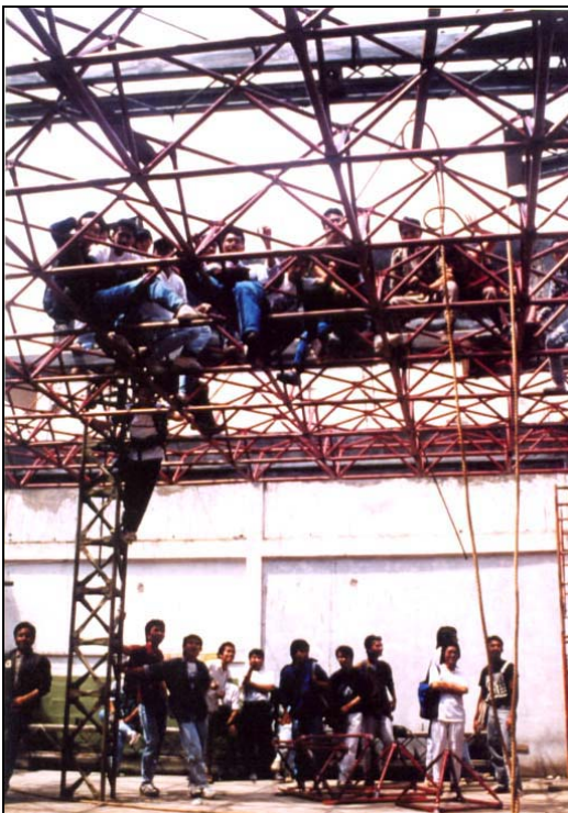
Foto 12. Penyelesaian pengangkatan pada ketinggian 4 meter. Perampungan perakitan unit rangka ruang baja, sepanjang keempat sisi dinding.
