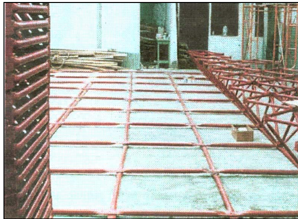
Foto 3. Perakitan dimulai dengan menyusun rangka batang bawah. Penyusunan ini sesuai pola penempatan unit rangka ruang, sesuai pola yang telah direncanakan.
