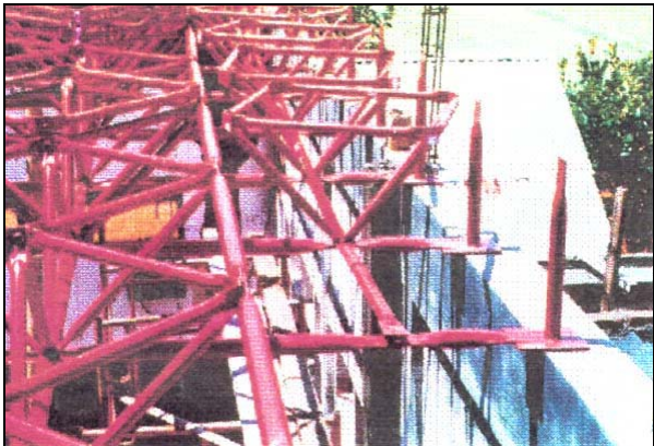
Foto 12. Penyelesaian pengangkatan pada ketinggian 4 meter. Perampungan perakitan unit rangka ruang baja, sepanjang keempat sisi dinding.
