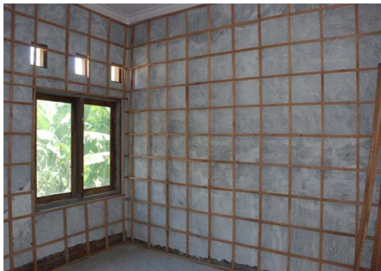
Gambar 4. Ruang uji yang telah dipasang rangka, dipersiapkan untuk dipasang panel jerami
