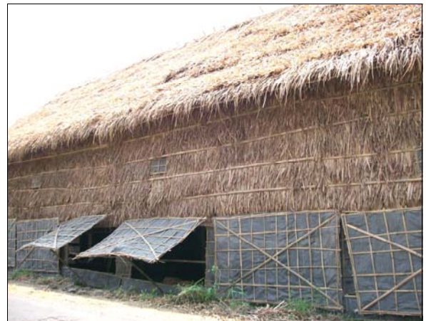
Gambar 21. Dinding los dan jendela ( kelep ) yang bisa dibuka.
