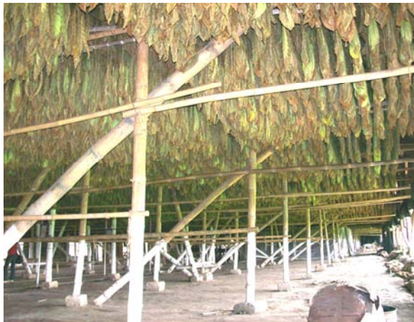
Gambar 12. Tiang-tiang penyangga dari bambu, berfungsi untuk menggantung dolok .
