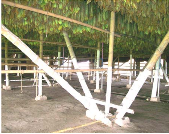
Gambar 11. Tiang-tiang ( jontong ) utama bangunan dari bambu.
