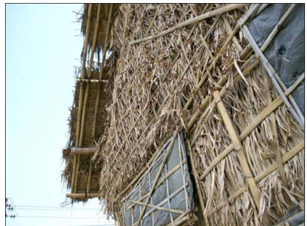
Gambar 20. Dinding los dan jendela ( kelep ) yang bisa dibuka.
