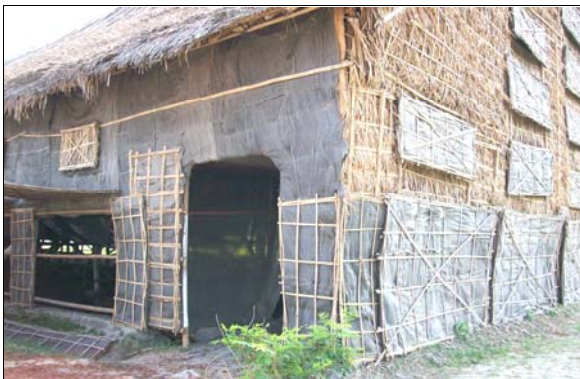
Gambar 18. Dinding los dari kepeng , rapak , goni; juga plastik, jaring-jaring. Pintu masuk di bagian tepi los.
