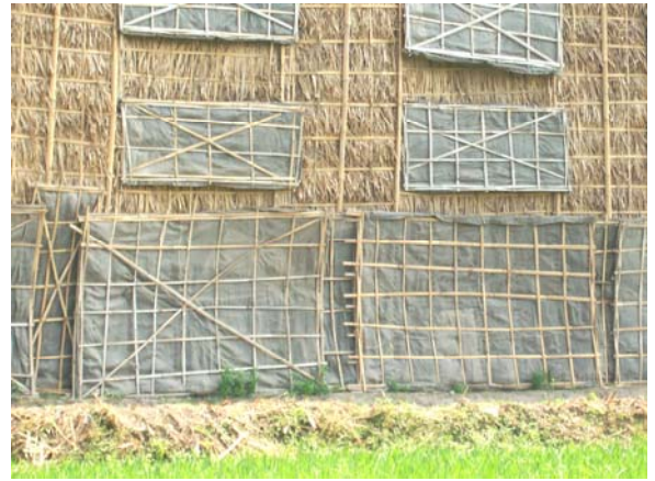
Gambar 19. Dinding los dan jendela ( kelep ) yang bisa dibuka.
