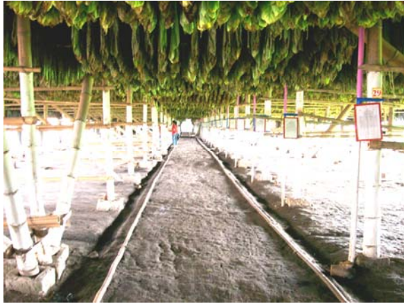
Gambar 22. Lantai dari tanah, parit kecil diberi pembatas bambu.
