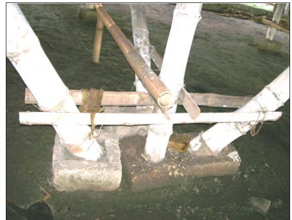
Gambar 10. Umpak batu dan tiang-tiang ( jontong ) utama bangunan dari bambu
