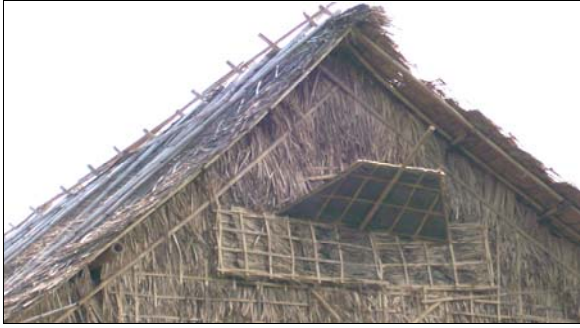
Gambar 16. Atap, dinding los dari rapak .
