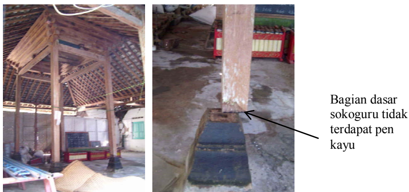
Gambar 1B. Pendopo joglo pasca gempa dengan tumpuan tanpa angker
