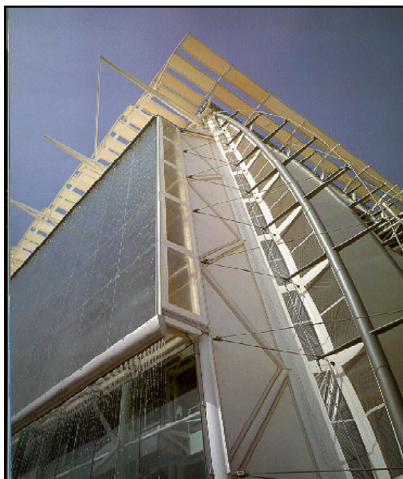
Gambar 2. Sisi Bagian Timur yang Diberi Tabir Air pada Dinding Kaca Mampu Menurunkan Suhu di dalamnya Hingga Sekitar 10° C
