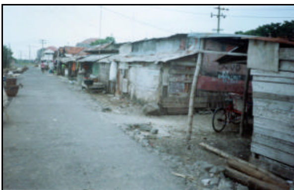
Kondisi Rumah Nelayan yang tidak layak huni
