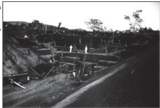
Gambar 1B. Pembuatan jalan kereta api diatas sungai Citarum, antara Cianjur dan Bandung. Karena medan yang berat tersebut pengerjaan jalan Kereta Api tersebut memerlukan waktu lebih dari 6 tahun. Dari th. 1878 sampai 1884
