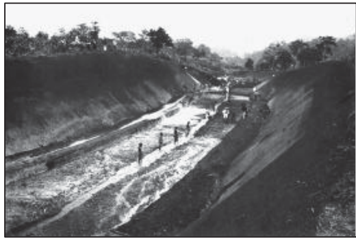
Gambar 1A. Pembuatan konstruksi jalan kereta api antara Cianjur dan Bandung. Keadaan fisik yang berat dan tidak menguntungkan ini memerlukan banyak sekali tenaga kerja
