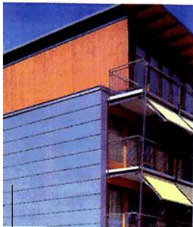
Deretan Modul PV sebagai penutup facade
