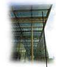
Generasi ke 3 Deretan Modul PV Sebagai penutup Atrium
