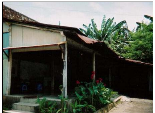
b. Bangunan inti Komplek Dalem Wiryadiningratan
