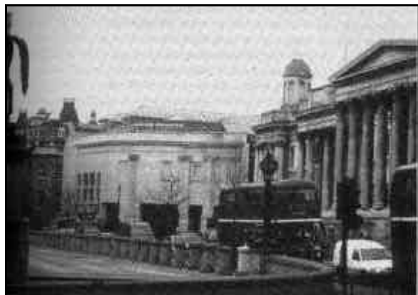
Gambar 3. Perluasan Sayap Bangunan The Sainsbury, National Gallery
